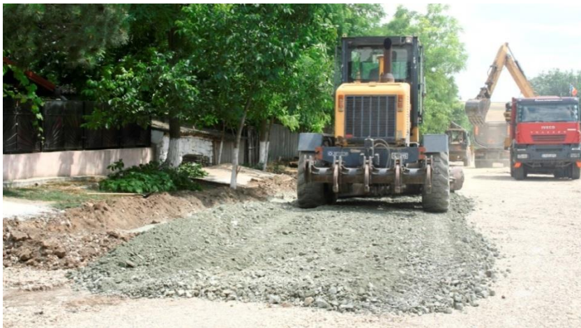
Foto nr. 18-20 – Reabilitare și modernizare străzi în comuna Albești, județul Constanța 6
